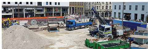
Die Baustelle am Marienhof wird für Anwohner zur Belastung
